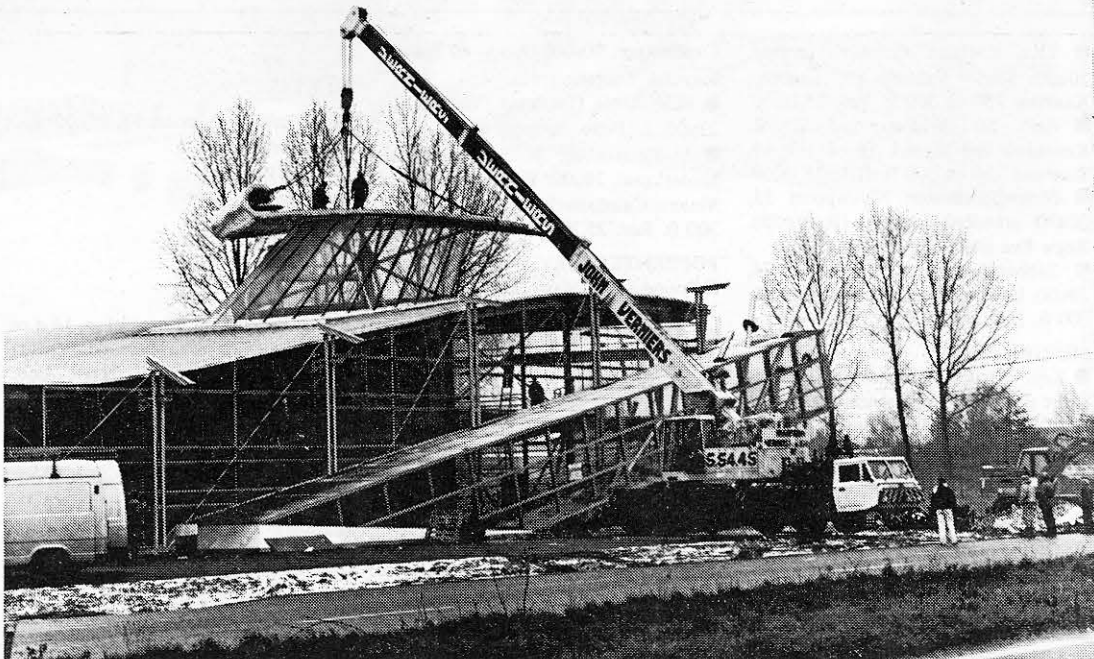
Een spektakulaire dakbevestiging op een spectaculair gebouw. (Foto Rol-Action)
