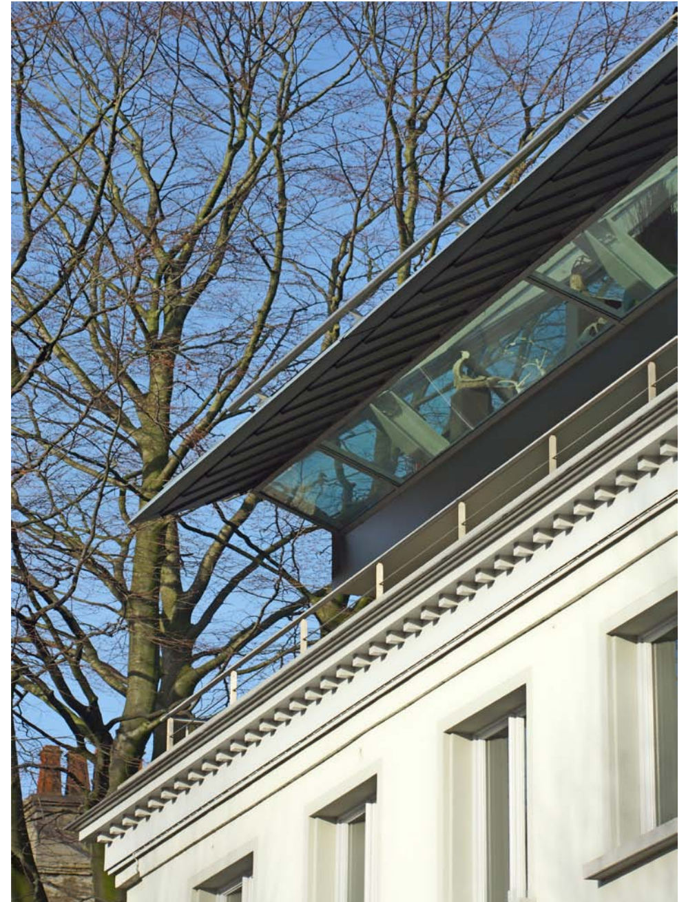
Het gebruik van de bestaande kroonlijst als een onderdeel van de balustrade accentueert de communicatie van het nieuwe dak met het gebouw. Het beglazen van de onderzijde van het nieuwe dak biedt zicht op het water van de coupure en verzelfstandigt het zwevende dak.
